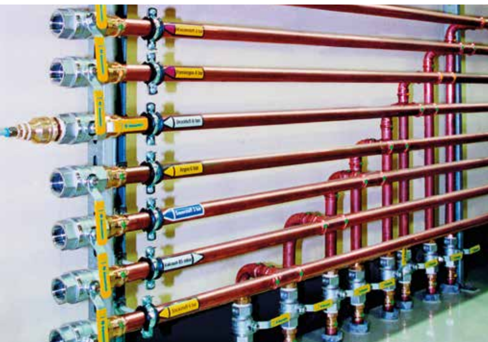
Obr. č.9 Systém distribuce technických plynů, realizace s lisovanými tvarovkami (DKI 6025).
