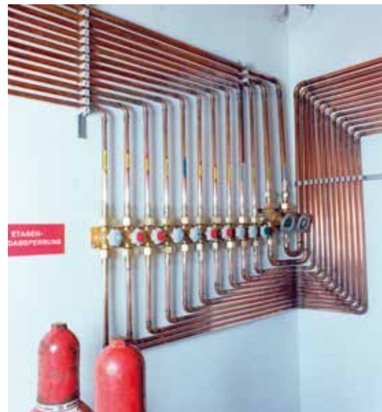
Obr. č. 7 Lékařský systém dodávky plynu se značením potrubí (Drägerwerke).
