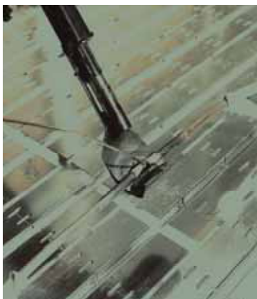
Obr. 6. Pájení měděných trubek podlahového vytápění
