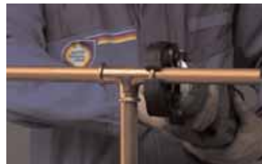
Obr. 7. Lisování spoje
