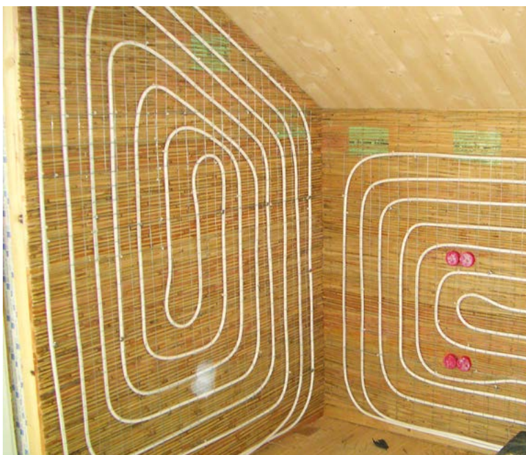
Stěnové topení z opláštěných měděných trubek v podkroví
